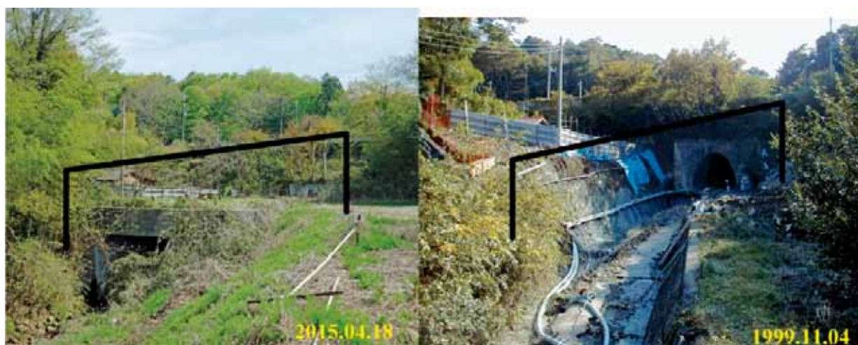
図2. 露頭付近の現況と観察時点の比較. 黒線の幅部分が露頭.
