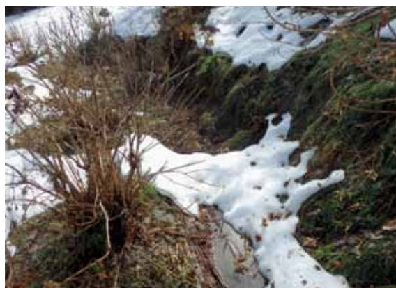
写真2 実験をおこなった水路
