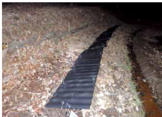
写真8 畦板を使用したシェルター
