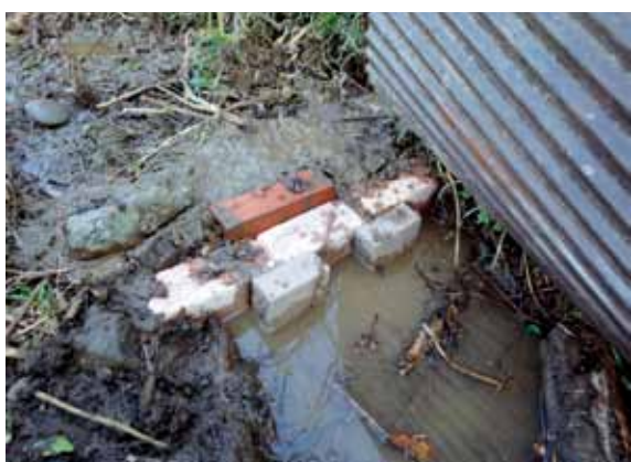
写真3 煉瓦を使用した土止め
