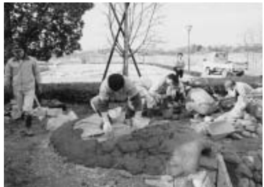
④天井になる土を積みます
