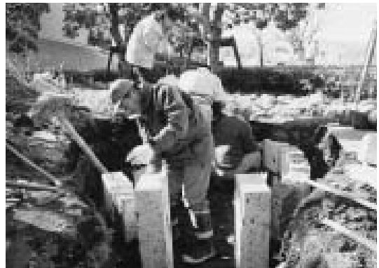
②大谷石を積み上げて壁を作ります
