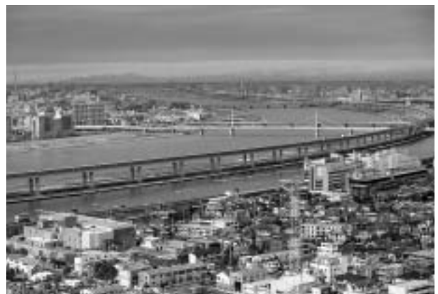
[荒川河口付近] 手前を流れているのは中川、間を走っているのは首都高速中央環状線
