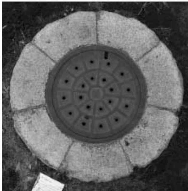
上から見たマンホール
