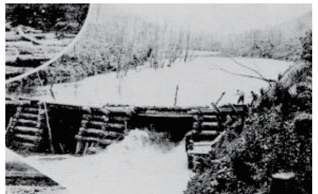
写真④ サハリンの川（旧名“古丹岸川”）に築かれた鉄砲堰。木材の組み方は秋田式であるが、放水口の開け方は越中式であり、改良型と考えられる。
