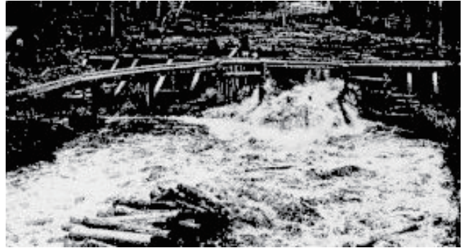
写真③ ホロカビリベツ川に築かれた秋田式鉄砲堰（昭和25年4月撮影）。放水した瞬間約五秒後の写真という。
