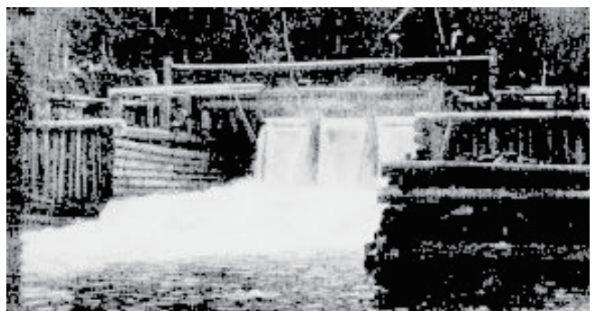
写真② ビリベツ川本流に築かれた秋田式鉄砲堰 (昭和25年4月撮影)。放水口の板を止めておく大坊主と呼ぶ木材が2本造られている。
