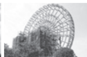
「水受け」の取り付け完了
