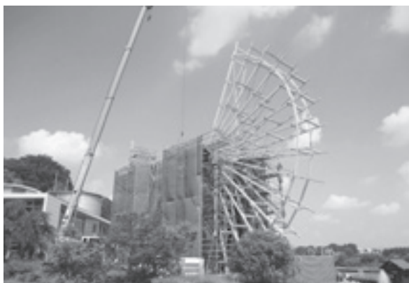
写真② 組み上がっていく大水車
