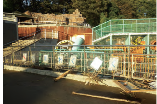
わくわくランド内外に流木や土砂が残り、一部破損
