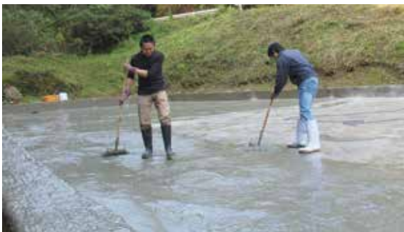
ひび割れの修復にモルタルを塗る
