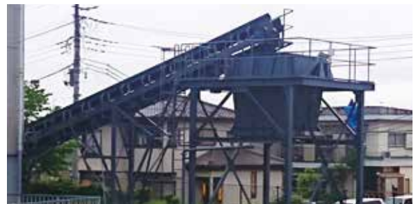
写真はベルトコンベアです。運ばれたごみは、そのままトラックの荷台に落として回収出来ます。
