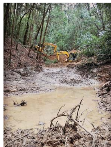
写真4. 炭釜谷戸の最上部での重機を入れた工事 (2020年4月9日撮影)
