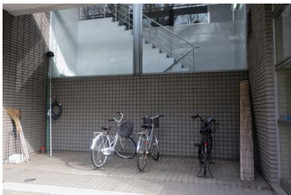
図3 本館南側職員自転車置き場付近（A地点）
