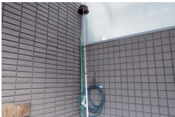
図4 A地点左側に備えつけられている清掃用具とホース
