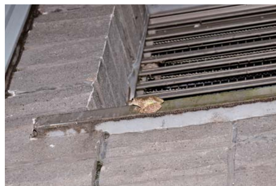
図8 排気口の窓枠のカジカガエル成体（A地点，2021.10.6）
