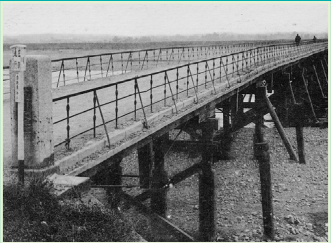
絵はがき「初代の荒川大橋」(土木学会附属土木図書館所蔵)
