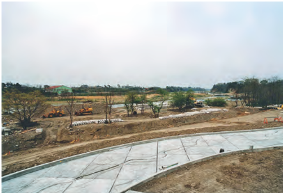
図6 かわはくオープン前の工事中の写真 大模型が設置途中で、北側の植生と東側の自然植生が見える。
