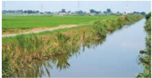
開削当時をしのばせる素掘り水路
