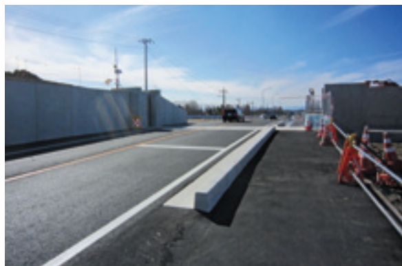
整備途中の陸閘
