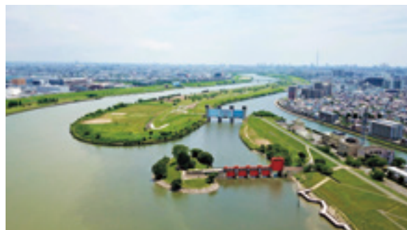
上空から臨む新・旧岩淵水門 （写真提供：国土交通省 荒川下流河川事務所）
